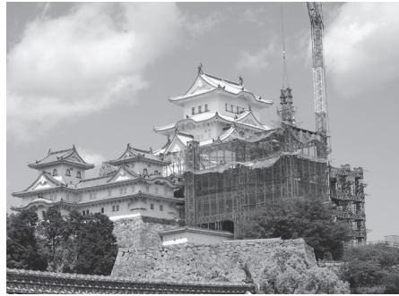
写真 176 姫路城「平成の大修理」(姫路市提供)
