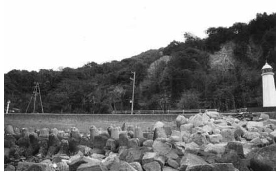
写真 21 津名郡北淡町野島江崎の山腹崩壊被災状況 4)
