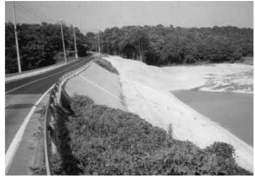
写真 26 奥池（三木市） 復旧工事完了 1)
