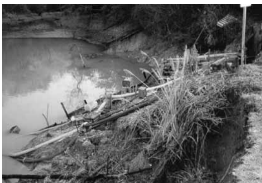
写真 23 二六池（小野市） 緊急ポンプ排水 1)
