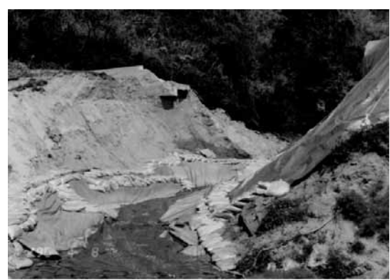
写真8 泉中池（津名郡北淡町） 緊急堤体開削応急工事 1)
