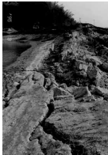
写真6 井手の尻池（津名郡 一宮町）崩壊状況と池 敷内の噴砂
