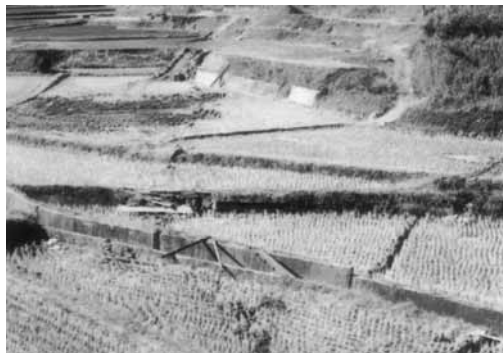
写真9 野島地区（津名郡北淡町） 断層による田面の亀裂 1)
