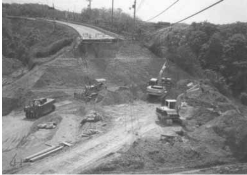
写真 25 奥池（三木市）復旧工事 1)
