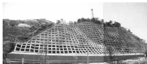
写真 31 津名郡北淡町野島江崎 山腹復旧工事 4)
