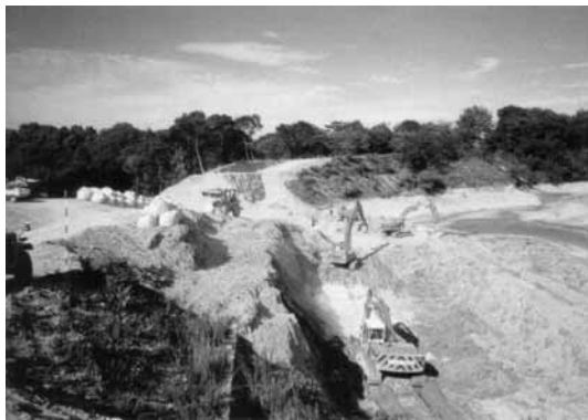
写真 27 大堤防池（神戸市西区） 復旧工事 1)
