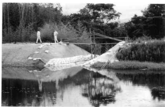
写真 24 遊岩上池（神戸市西区） 応急洪水吐工事 1)
