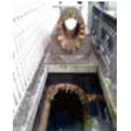
5 旧居留地煉瓦造下水道
