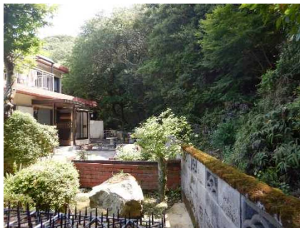
③保全対象(人家)
