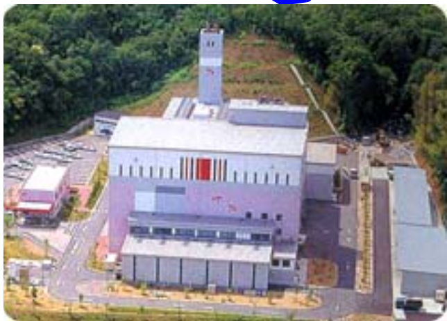
広域ゴミ処理施設(揖龍クリーンセンター)
