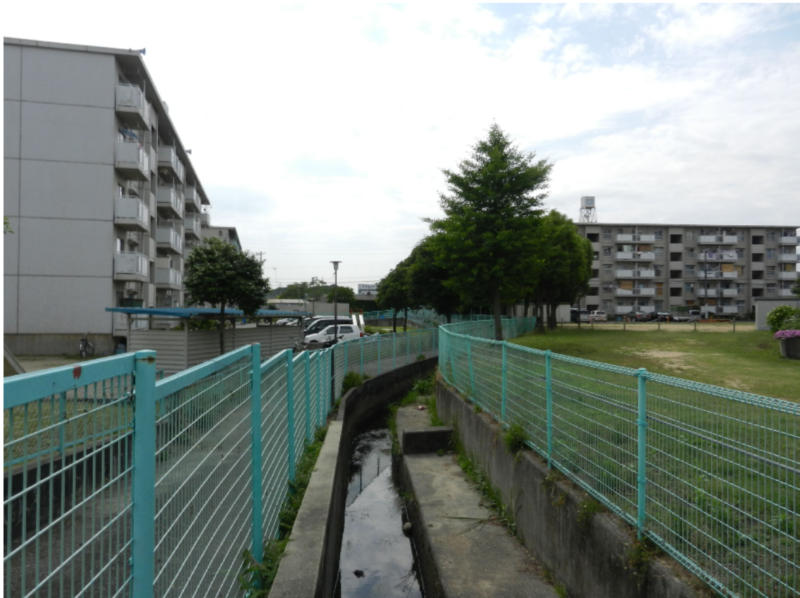
姫路御着住宅現状写真 外観 4：敷地内を流れる水路の状況
