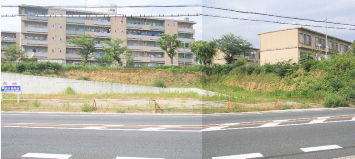
姫路御国野住宅現状写真 外観 1：住棟南側より
