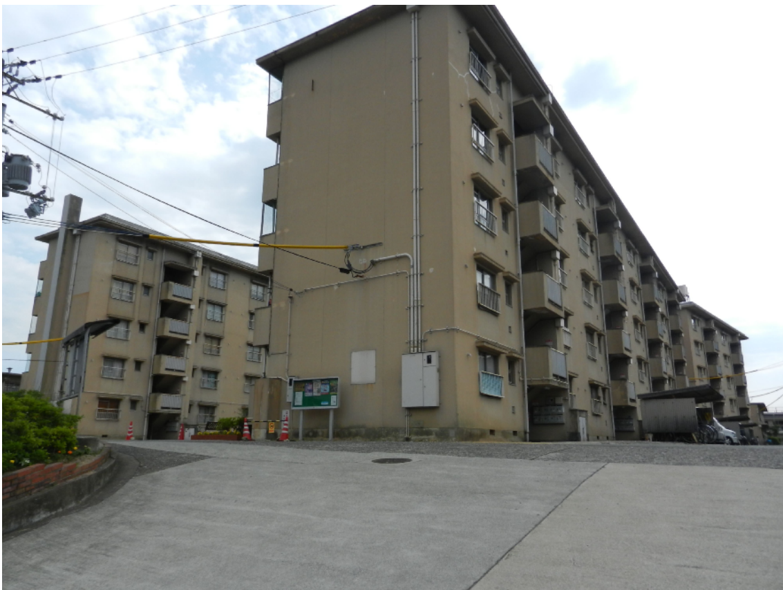
姫路御国野住宅現状写真 外観 2：住棟北東側より
