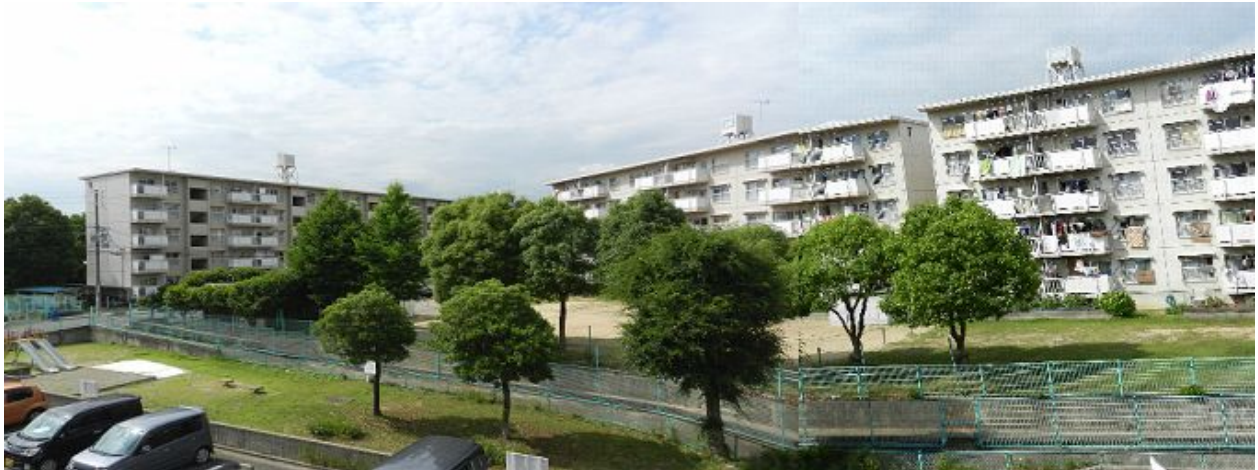
姫路御着住宅現状写真 外観 3：住棟南側より
