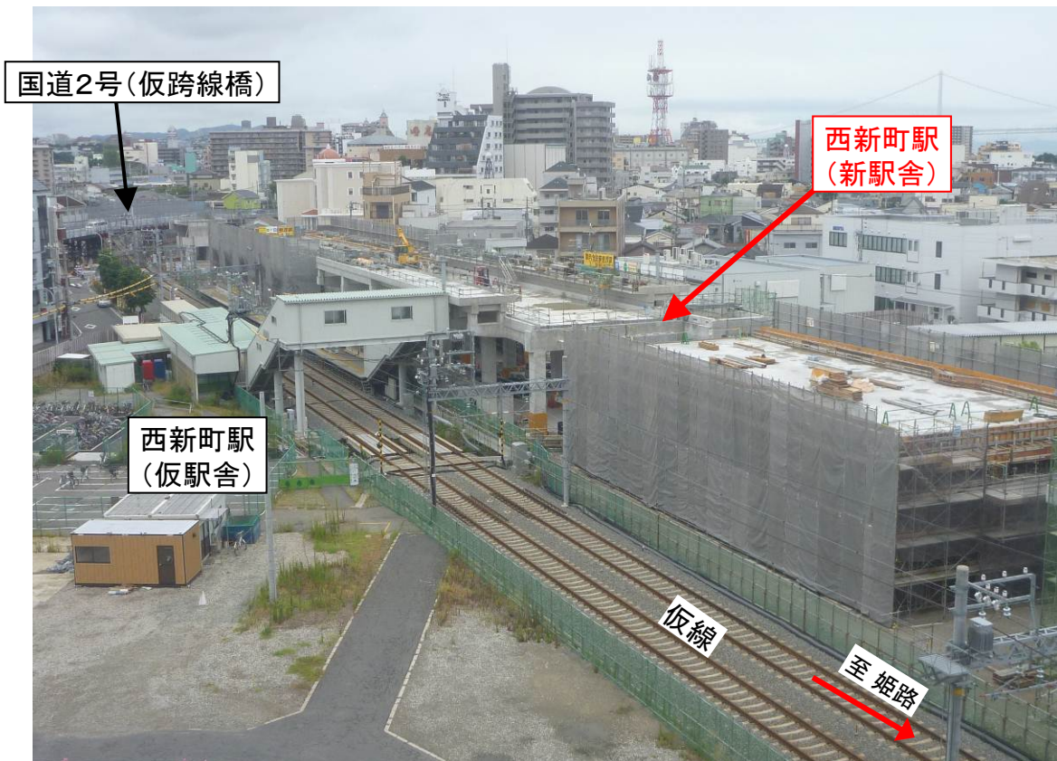
高架本体工事（西新町駅部）
