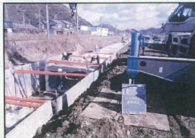
雨水渠設置工事(ボックスカルバート布設状況)
