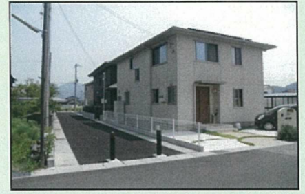
新たに造成した宅地 自転車歩行者道の新設
