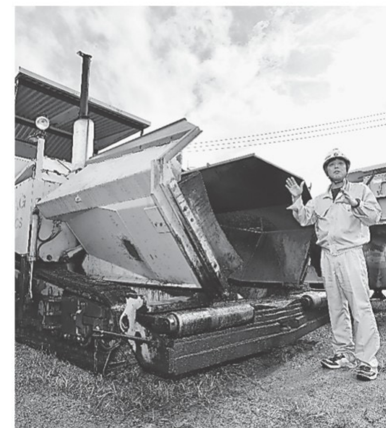
舗装作業で活躍する重機を説明する黒田さん＝淡路市志筑新島
