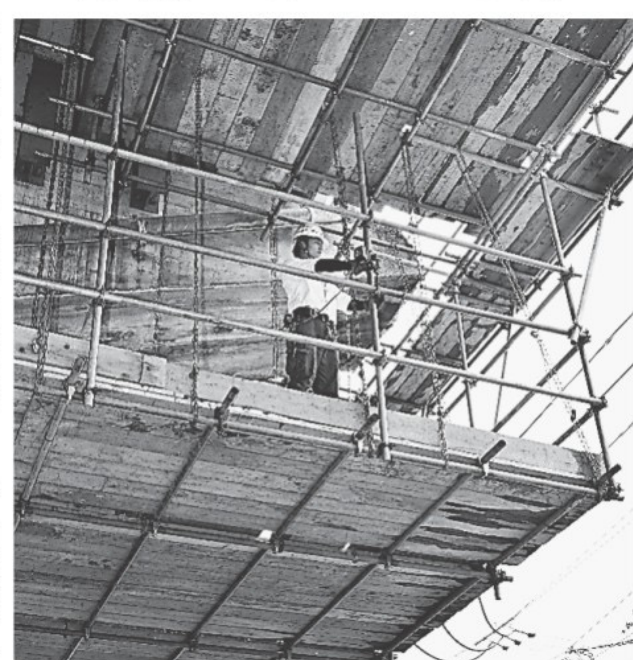
橋梁補修工事の「吊り足場」を組みあげる小林さん＝姫路市広畑区西蒲田
