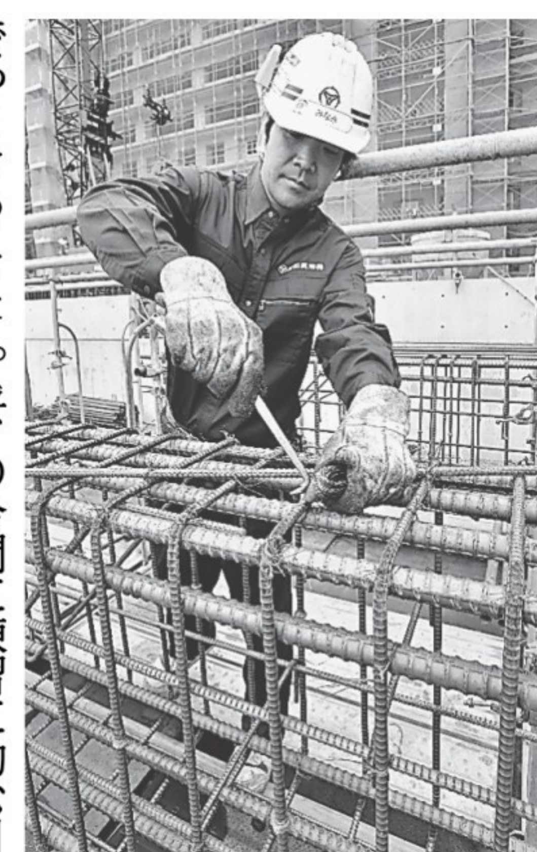
鉄筋工を針金で固定する南さん＝宝塚市東洋町
