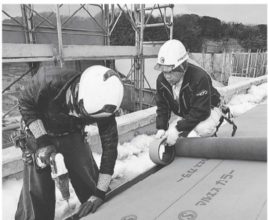
屋根部分に防水シートを打ち付ける。長持ちする屋根づくりがやりがいと言う二位剛さん(右)
