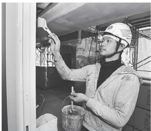
玄関の塗装をする日置一馬さん。仕上がり左右する養生作業は特に神経を使う
