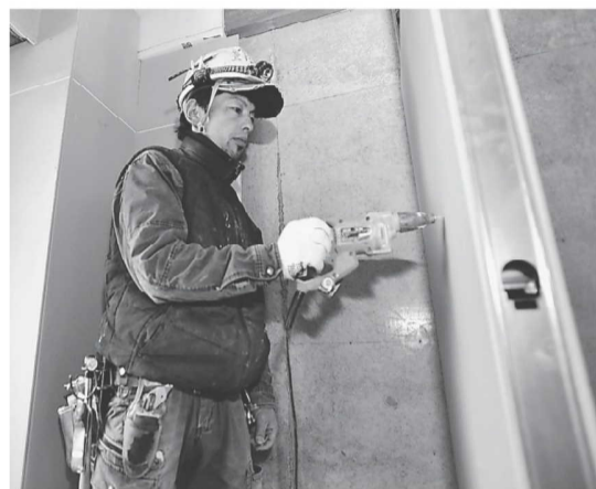
内装のボードを固定する炭屋広志さん。コンマ5ミリの精度を美学にして仕事に向き合っている
