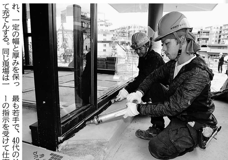
窓枠と本体の間にシーリングを打つ緒方翔平さん(手前)。グループのリーダーが作業を見守る
