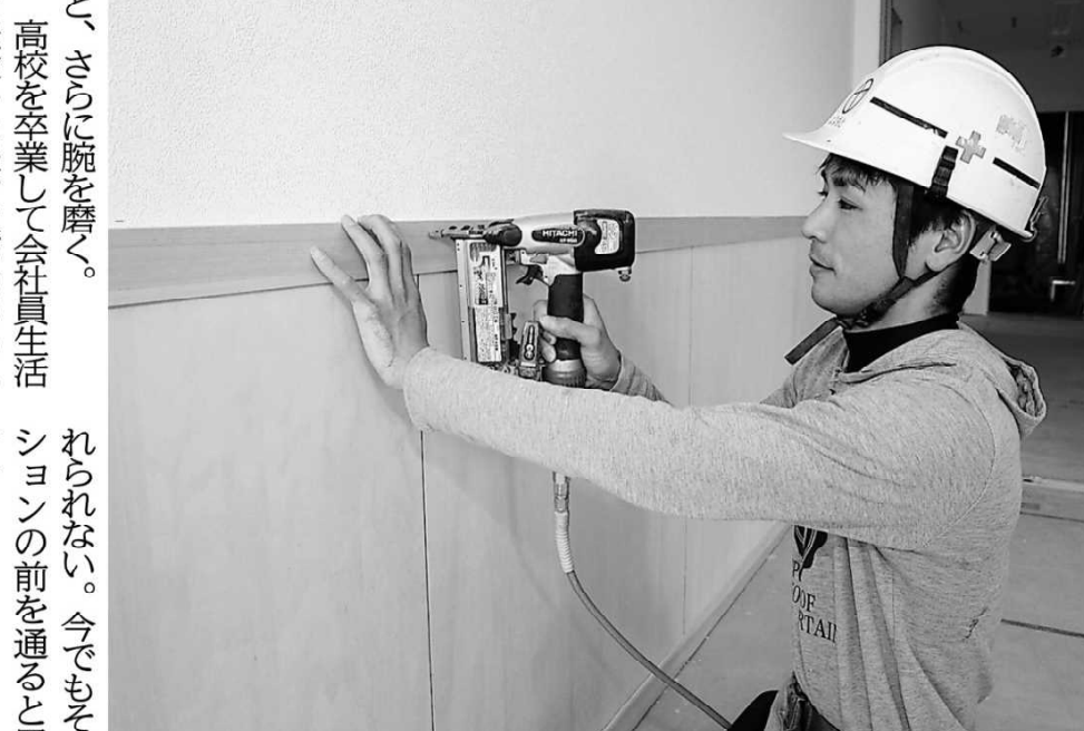
壁面の仕上げ材が変わる部分に、見栄えが良くなるよう化粧材を設置する花元昭太さん
