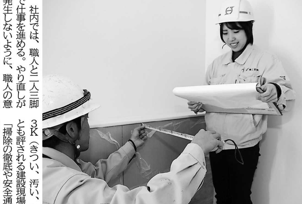
自分が設計した棚を取り付ける現場で、図面を手に打ち合わせする土居裕子さん(右)
