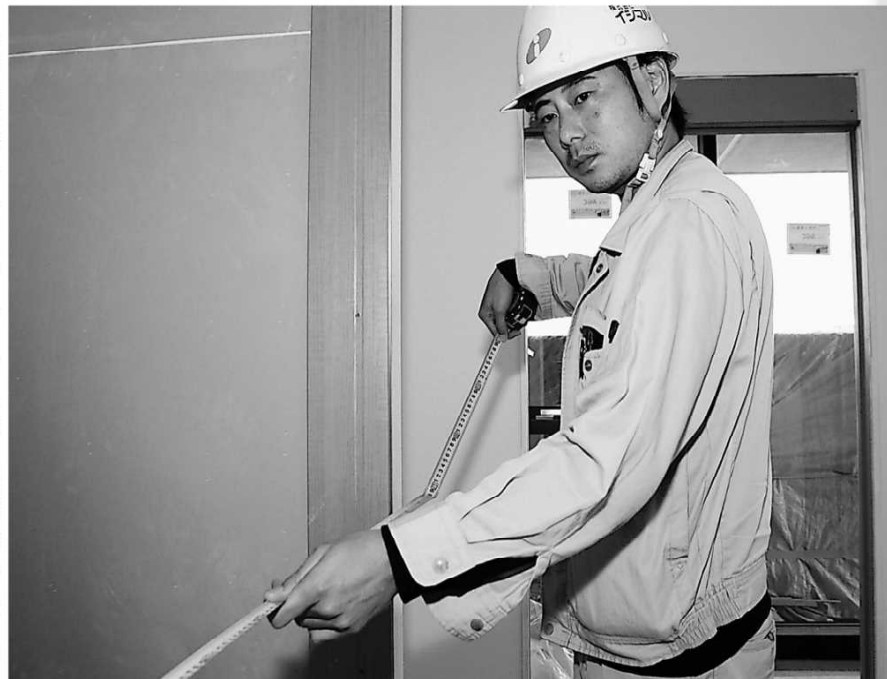
木製の室内扉を設計するため、現場で採寸する河上良さん。建具が設置されれば、建物の完成も間近だ
