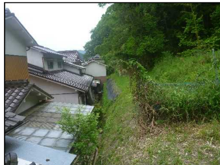
③ 保全対象とがけの状況
