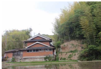
③保全対象とがけの状況
