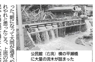
公民館(右奥)横の平瀬橋に大量の流木が詰まった。
