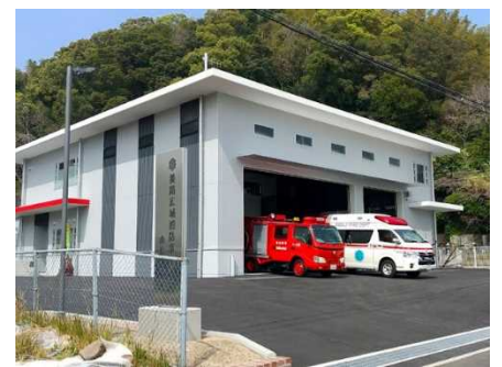
④保全対象(消防本部由良出張所)
