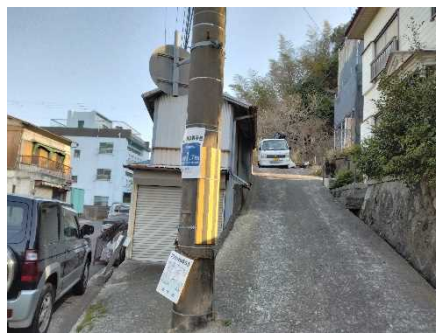
③保全対象(人家)
