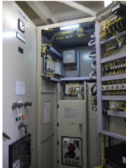
図 4-59 変電設備の更新（京都丹後鉄道）
