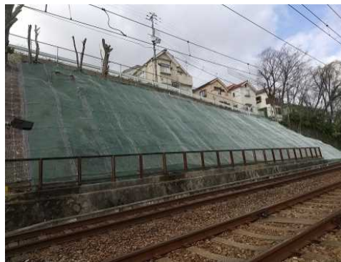
図 4-56 斜面崩壊の事前対策
