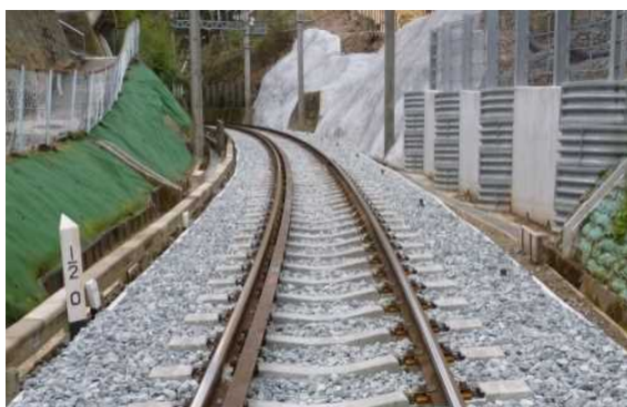
図 4-56 斜面崩壊の事前対策
