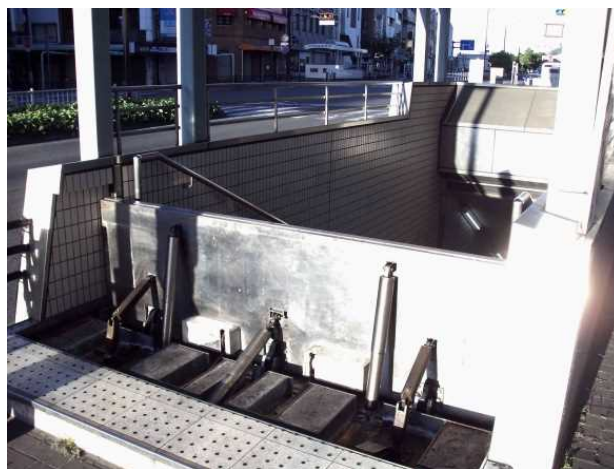
図 4-57 駅の浸水対策（山陽電鉄）
