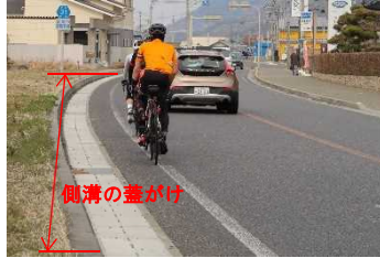
狭隘区間での路肩幅確保
