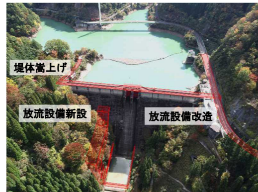
〔②既存ダム〕引原ダム[ダム再生](宍粟市)
