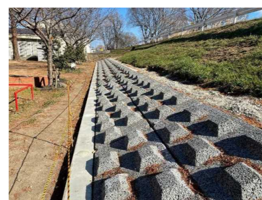
〔④堤防強化〕市川(姫路市)
