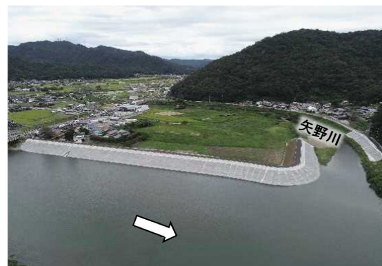
〔①河川改修〕千種川[護岸工](赤穂市)
