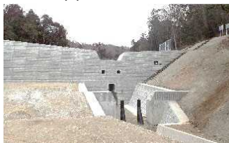
砂防堰堤の設置 (兵庫県 宝塚土木事務所)
