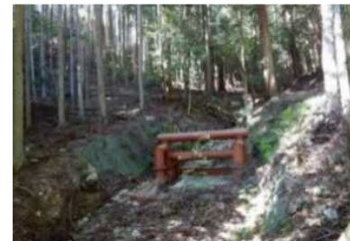
間伐及び簡易流木止の設置 (兵庫県 阪神農林振興事務所)
