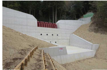
部分透過型治山ダムの設置 (兵庫県 六甲治山事務所)
