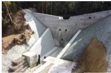
砂防堰堤の設置 (兵庫県 神戸土木事務所)
