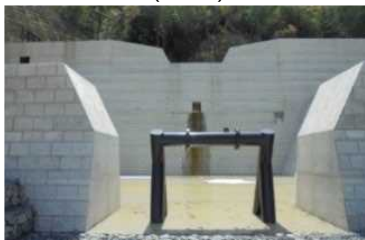
砂防堰堤の設置 (国土交通省 六甲砂防事務所)
