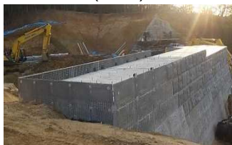
砂防堰堤の設置 (国土交通省 六甲砂防事務所)
