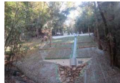
崩壊斜面を安定化させる土留工の設置 (兵庫県 六甲治山事務所)
