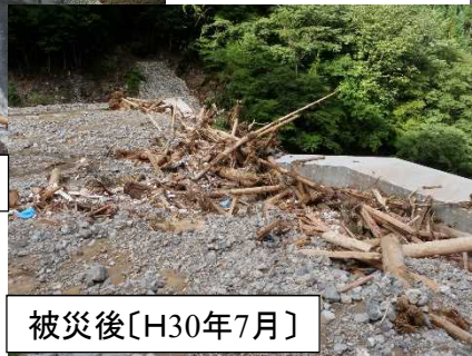
土石流を捕捉 (宍粟市)
