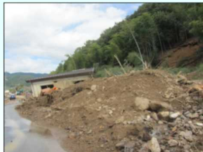
土石流による被害状況 (丹波市)
