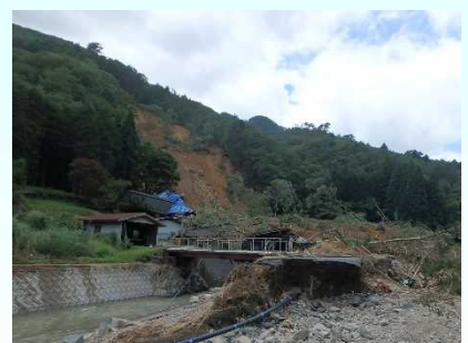
がけ崩れによる被害状況 (宍粟市)
