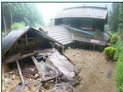
土石流による被害状況 (朝来市)
