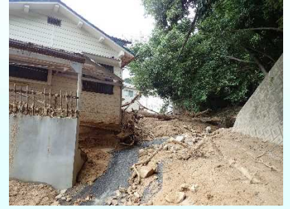
土石流による被害状況 (神戸市)
