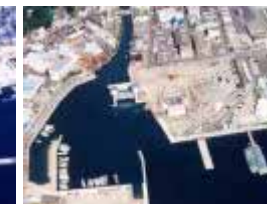
福良港海岸 (三原郡南淡町)
