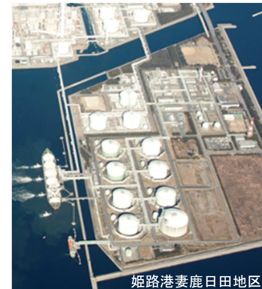
大型タンカー接岸状況
