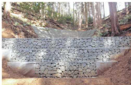
人家裏山の簡易防災施設の設置（鋼製かご砕工）
