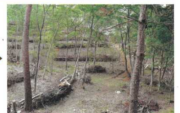
過密林の間伐後に、土留工を設置
