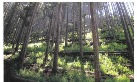
土留工の設置により下層植生が回復し表面侵食防止機能が向上
