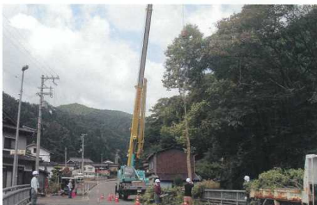
クレーンを用いた人家裏の危険木伐採
