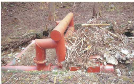
簡易流木止め施設が流木を捕捉
