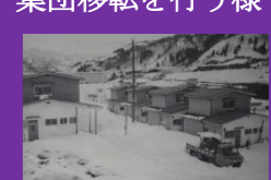
越冬住宅（共同牛舎も建設された）
