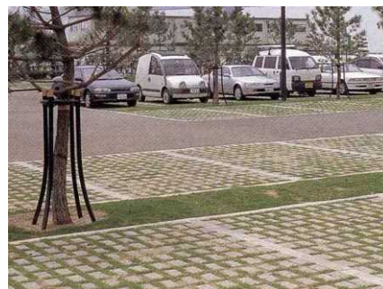
駐車部分の緑化舗装
