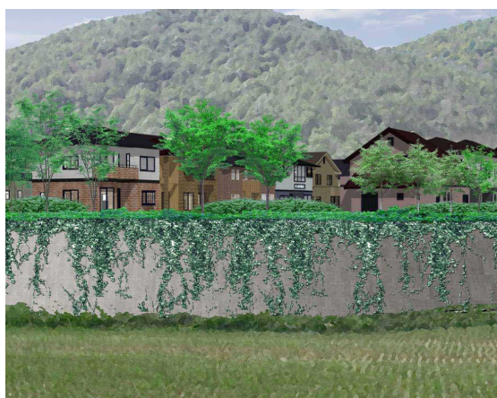
擁壁の緑化修景例
