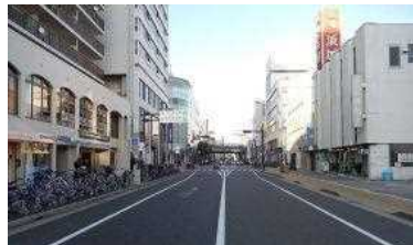
無電柱化整備状況(伊丹市)
