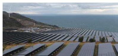
太陽光発電施設(淡路市)
