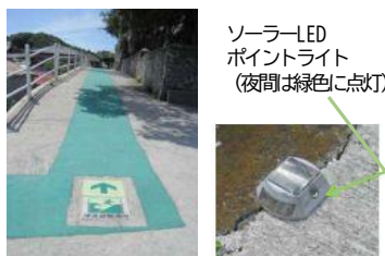
避難路のカラー舗装(南あわじ市)
