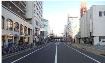
無電柱化整備状況(伊丹市)
