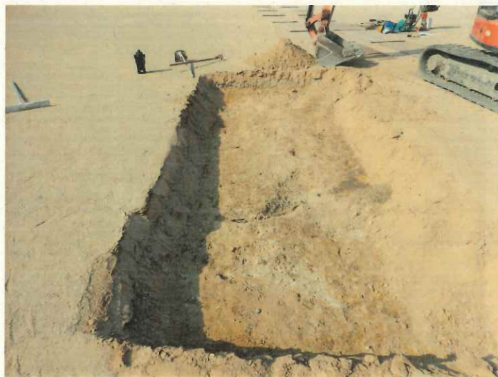
球技場（自転車競技場） 地区 1T 北から
