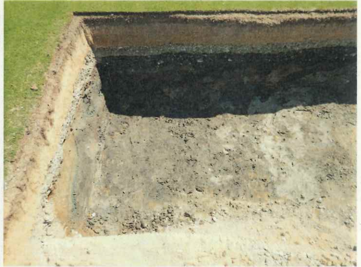
陸上競技場地区 2T 南壁 北から
