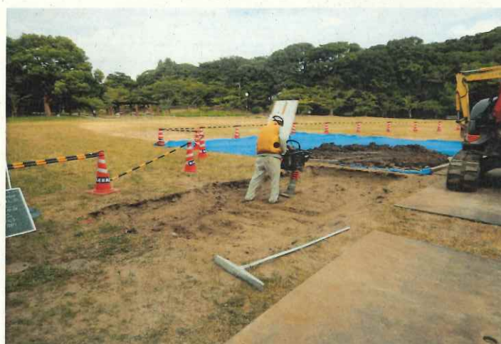
調査風景 埋め戻し
