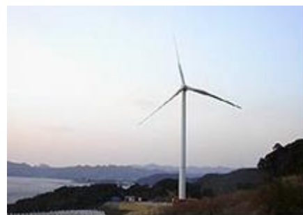
【風力発電施設の設置例】
