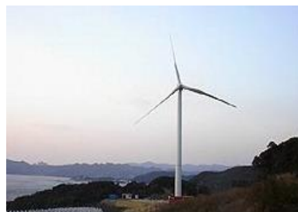
風力発電施設の設置例
