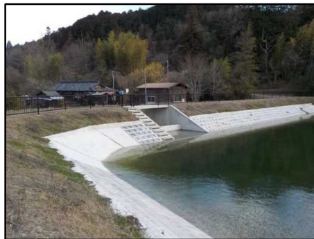
改修されたため池
