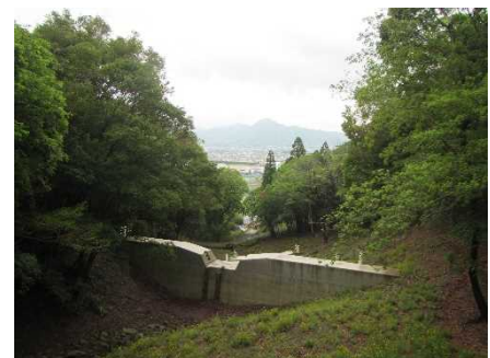
防災基盤整備（治山ダム）
