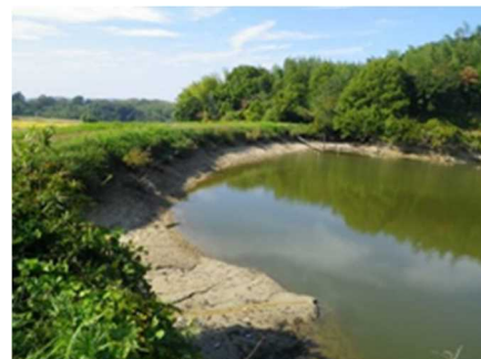
老朽化が進んだため池
