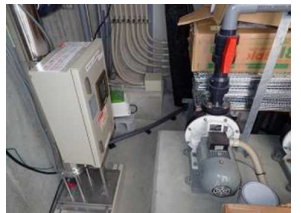
カキ水槽用減菌装置設置
