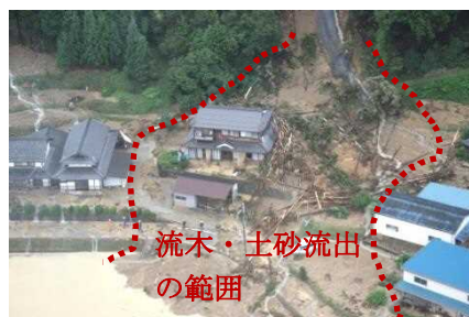
流木と土砂による家屋の被害状況 (丹波市市島町上竹田)
