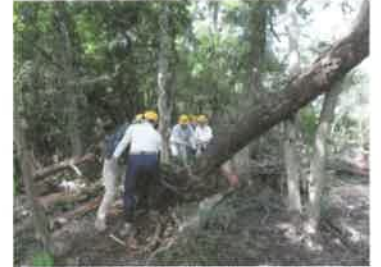
園路脇の枯れ松を伐採
