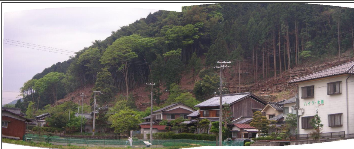
人家裏の里山林の整備状況《朝来市新井》
