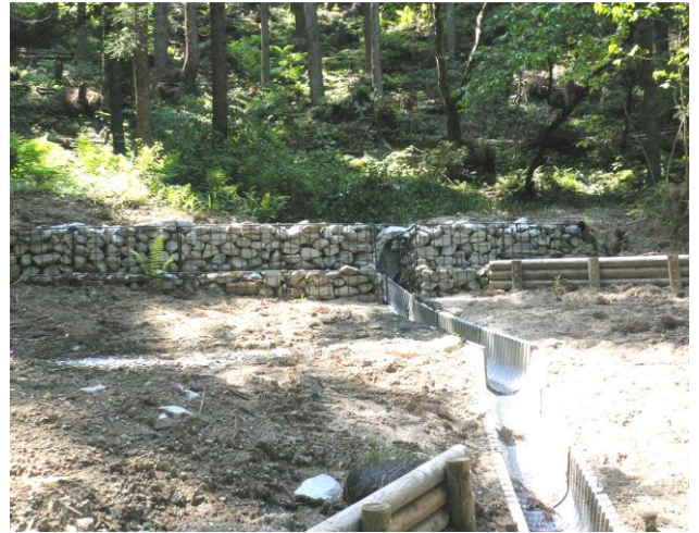
溪流の安定を図るカゴ枠工と水路工
