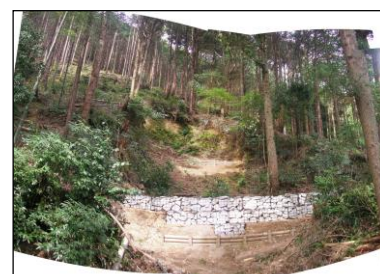
崩壊箇所の土留工
