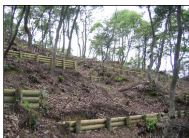
丸太柵工の設置
