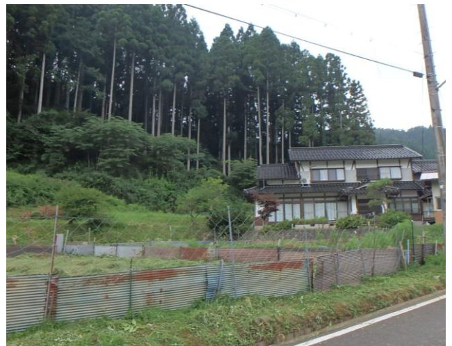
整備後10年状況
