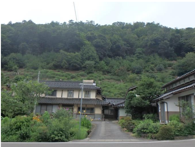
整備後15年状況
