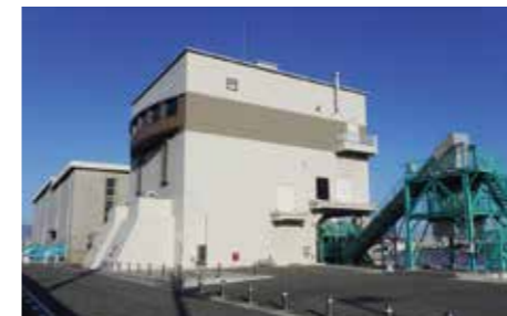
ポンプ場外観
