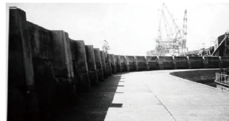
完成当時の防潮堤
