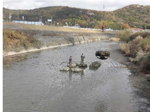
図16 石倉の設置状況(加古川)
