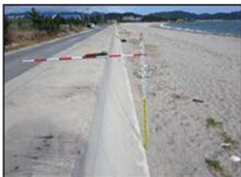
正常時の防潮堤
