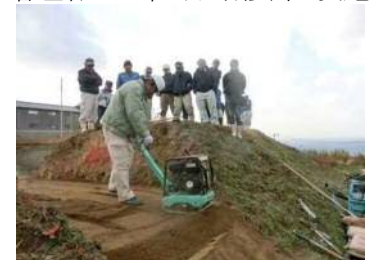
ため池堤体の補修指導
