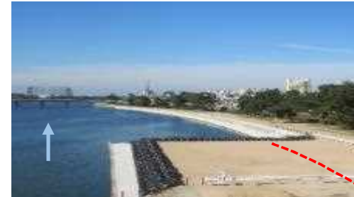
武庫川の河川改修 (赤点線：改修後の護岸の位置)
