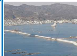
福良港 湾口防波堤
