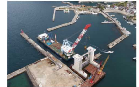
沼島漁港 水門整備
