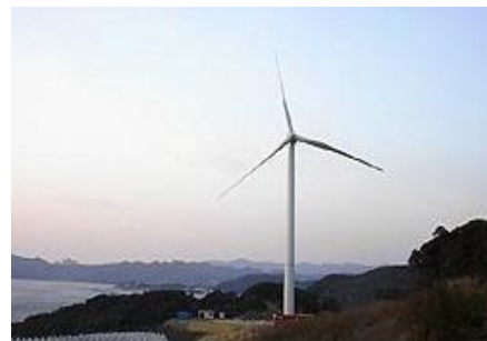
風力発電施設の設置例
