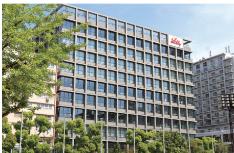
神戸本社の外観
