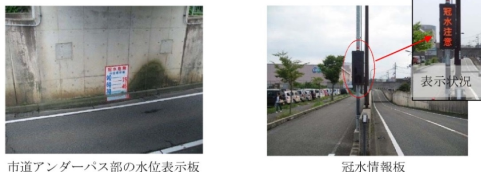
図 6.2.10 豊岡市の市道におけるアンダーパスの冠水情報板・水深表示板の例 (市道 大開一日市線 西花園架道橋)
