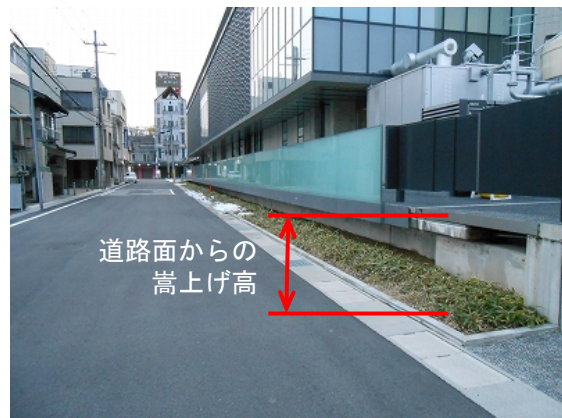
図 6.6.2 豊岡市役所の耐水化事例
