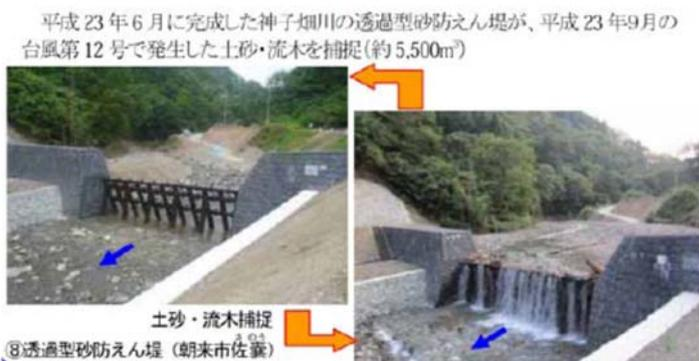
朝来市の神子畑川における砂防堰堤による土砂の捕捉状況（2011（平成 23）年台風 12 号）
