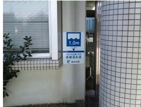
浸水実績表示板の設置事例
