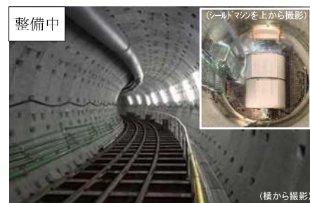
河川改修（地下貯留管）
