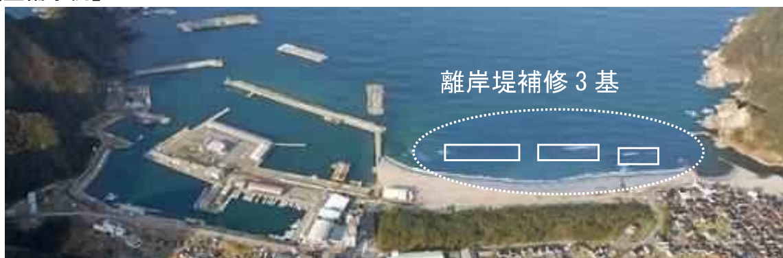
漁港海岸離岸堤補修
