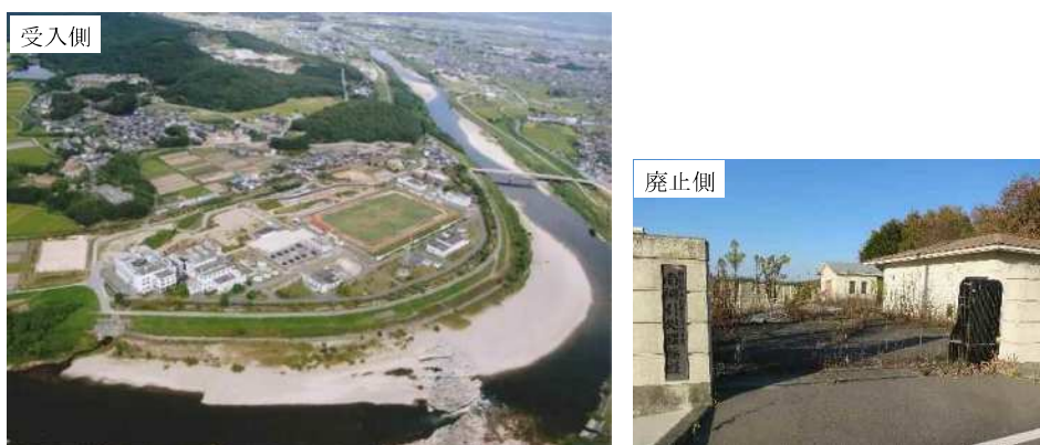
下水処理施設の広域化・共同化
