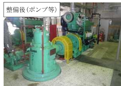
排水機場（ポンプ等修繕）
