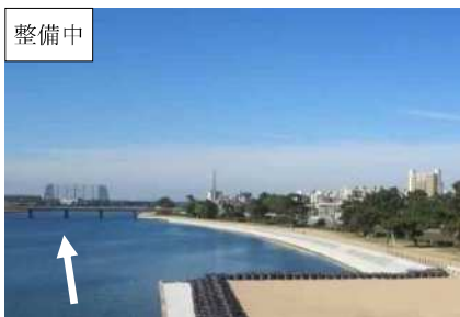
河川改修（護岸、河床掘削等）
