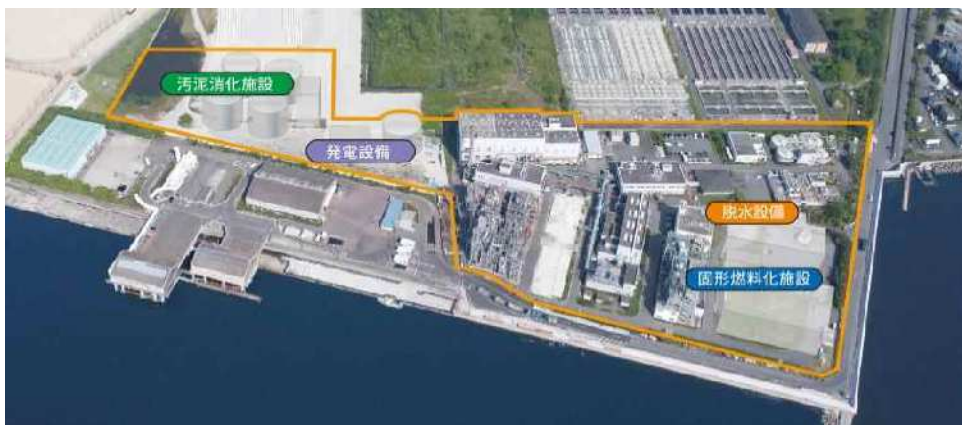
バイオガス・固形燃料を生成する施設（稼働予定）
