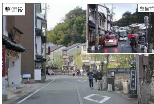
無電柱化対策
