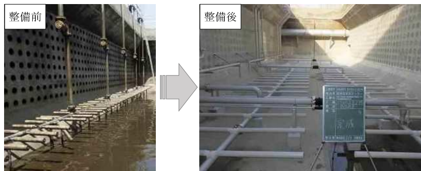
老朽化した散気装置を更新
