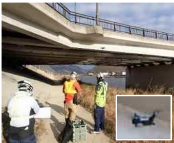
橋梁点検（ドローン撮影）
