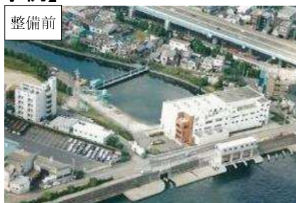
排水機場（更新）
