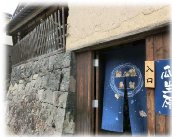
▲改修された瓜生原家住宅の川側の入口
