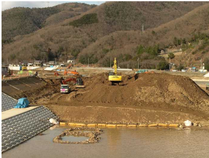
工事はまだ続いている
