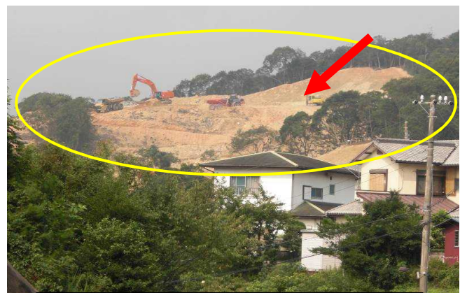
造成中の大規模ソーラー発電建設現場
