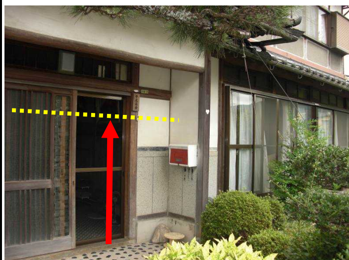
玄関は完全に水没した
