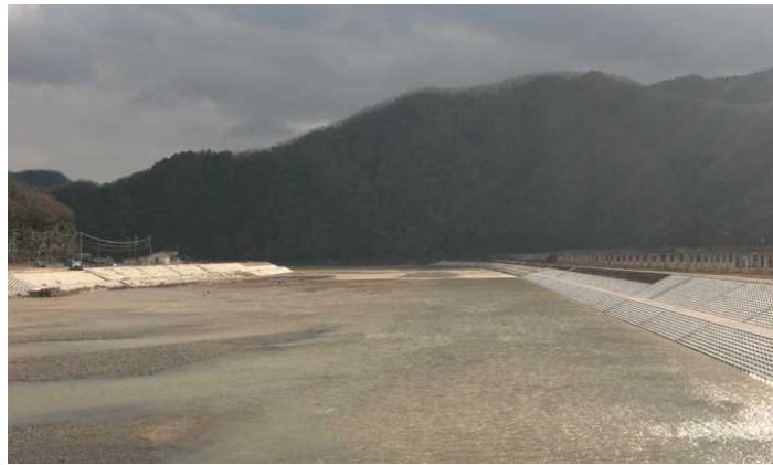
護岸工事が進む千種川
