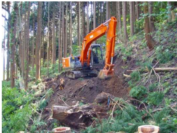
森林作業道開設
