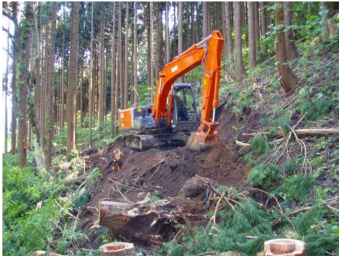
森林作業道開設
